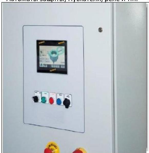
*ШУ Управления фризером на базе контроллера и сенсорной панели управления Schneider*
